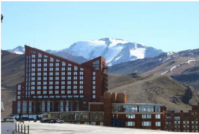
Fotografía 3 Hotel Valle Nevado, Farellones, Lo Barnechea
